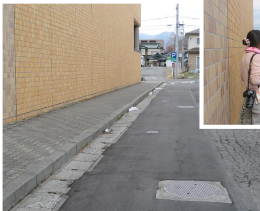
↑ 配水管を新しくしました
