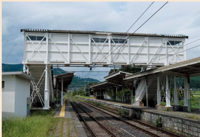
現在の小野駅(現代の跨線橋と異なり装飾が施されている)
