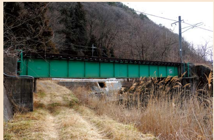
中央線開業当時に架けられたまま使われ続けている下雨沢鉄橋
