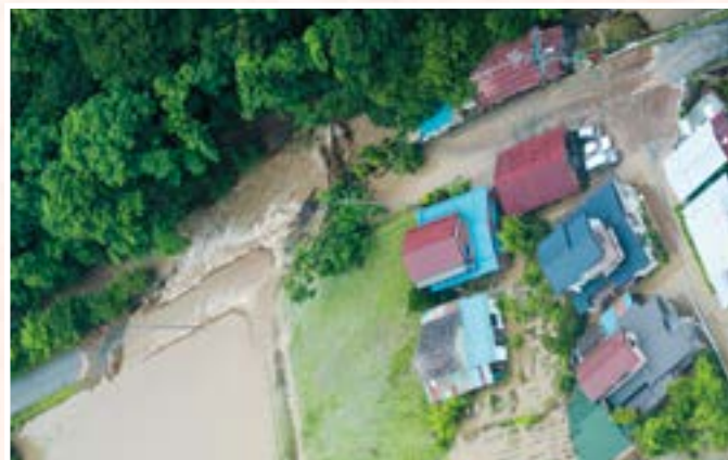
上島区 中の橋周辺の様子
