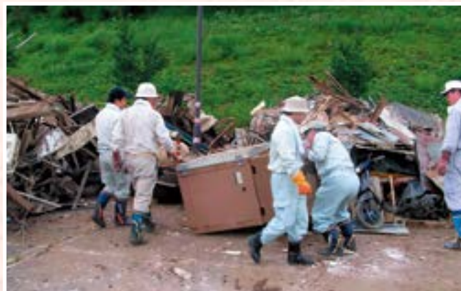
ボランティアによる復旧作業の様子
