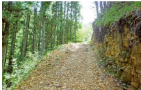
図 33 整備された作業道 (上田市教育委員会提供)
