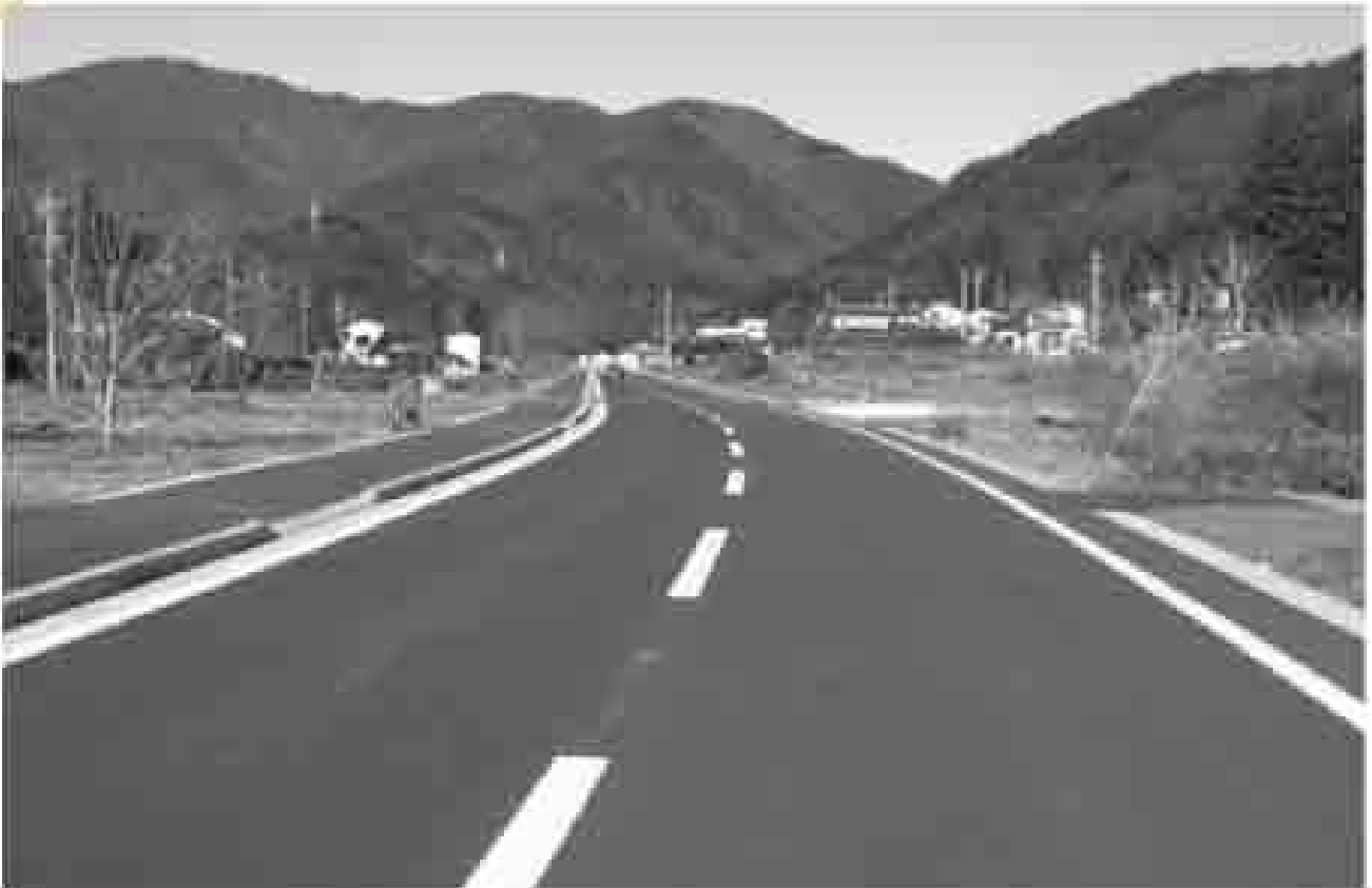
部分開通した中道線
