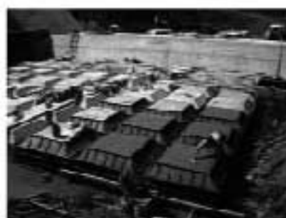
災害復旧工事中の東郷町
