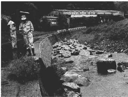
小横川川 道路災害復旧現場で
