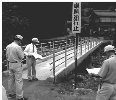
川島門前 沢口橋の現場視察
