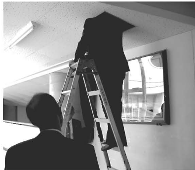
川島小学校のアスベスト調査
