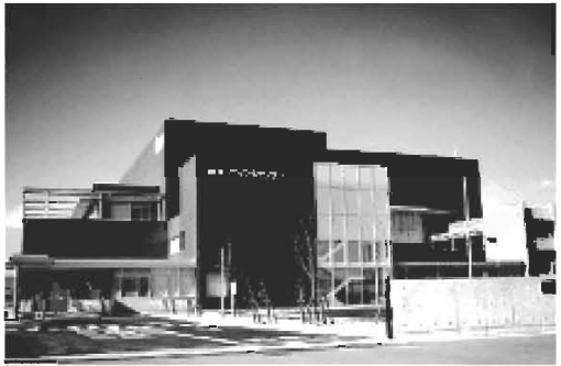
リサイクルセンター「炭生館」
