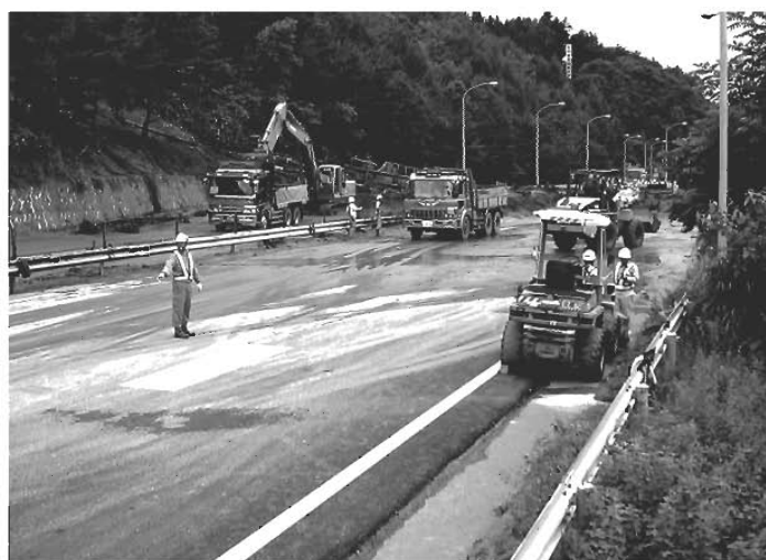
中央道／土砂流出復旧状況
