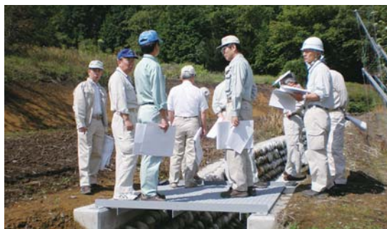
北大出大日尻地区の水路工事視察
