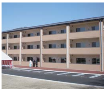
地域優良賃貸住宅平出団地
