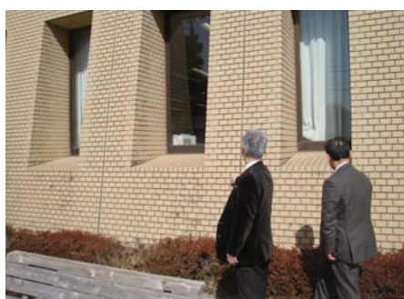
図書館外壁工事箇所
