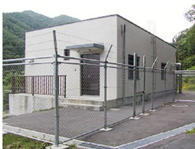
小野簡水飯沼浄水場
