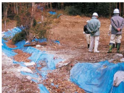
下飯沼沢流路工工事
