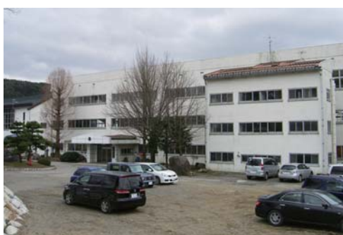
中学校耐震補強工事
