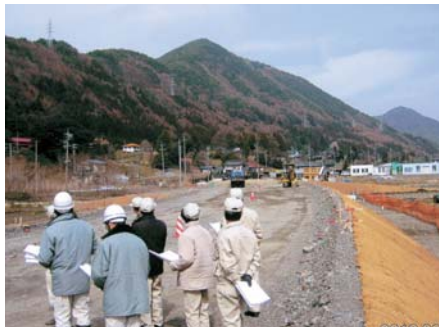
徳本水ミニバイパス配水管布設替工事
