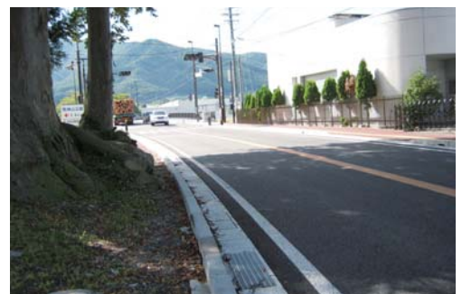
城前橋改築工事【辰中前】
