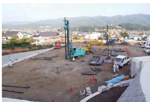
新町保育園建設現場
