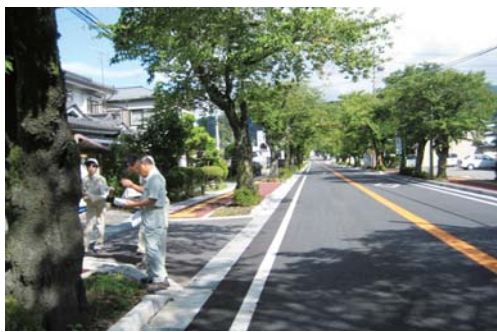
町道1号線工事【老人福祉センター前】
