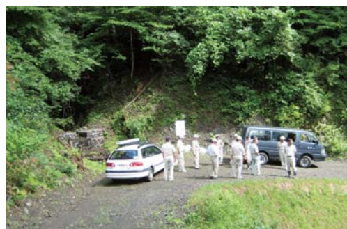
林道赤羽線災害復旧工事【河子沢】
