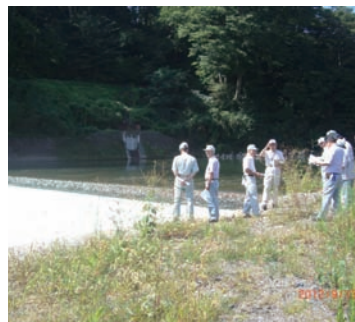
羽場下井頭首工復旧工事
