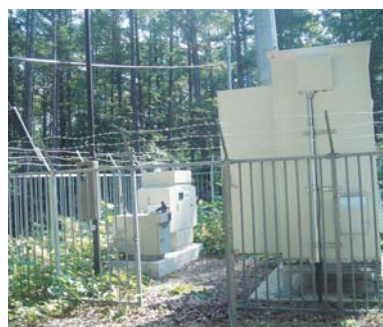
王城山防災行政無線デジタル化工事
