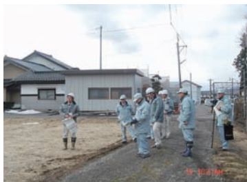
新屋敷線拡幅工事現場
