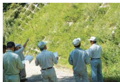
林道西部線復旧工事現場
