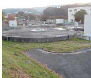
公共下水道水処理センター
