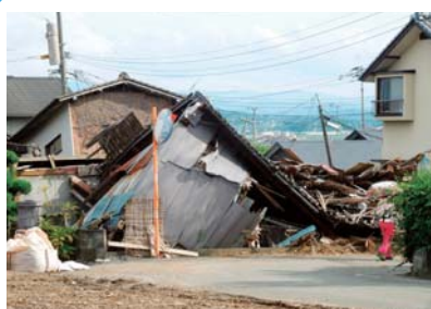
益城町の被災状況 (7/1)
