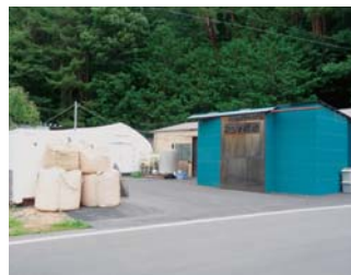
生ゴミを堆肥化している施設
