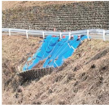
町道61号線工事予定箇所
