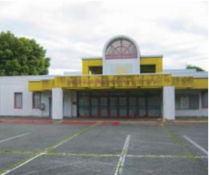
再生を待つ管理棟
