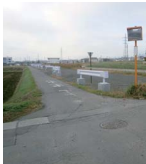
工事進む県道与地辰野線
