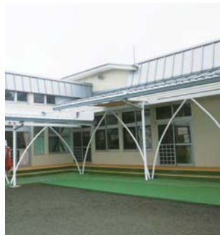
小野保育園耐震化工事
