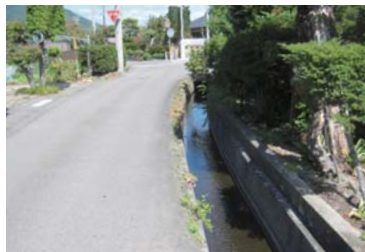
町道 2175 号線の現状
