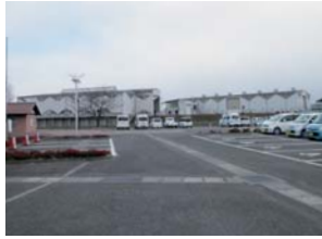
公共施設に隣接する山形村の最終処分場 (正面の体育館風の建物2棟)
