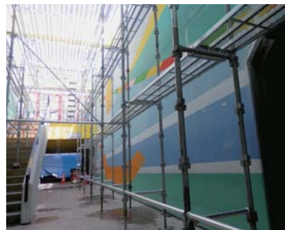
工事が進む荒神山旧プール管理棟内部
