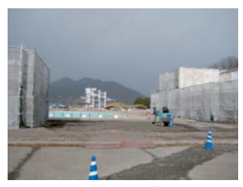
工事が進行する管理棟
