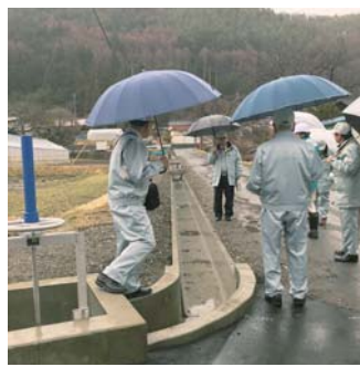
一ノ瀬工区水路改修工事現場
