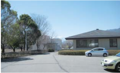
築 25 年経過した辰野水処理センター
