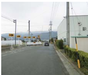
拡幅が望まれる下田踏切
