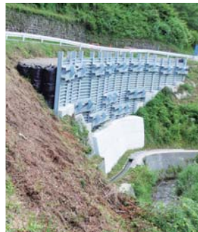
改良が進む町道61号線
