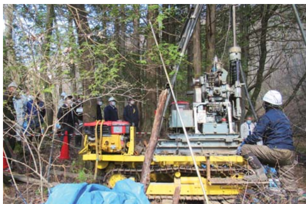
最終処分場予定地のボウリング調査
