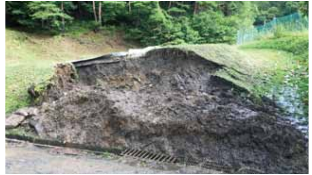
田んぼのり面の崩落
