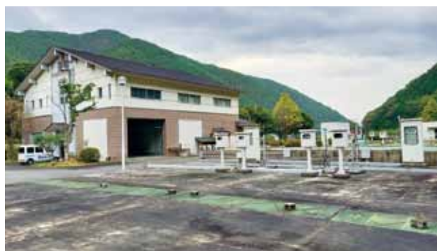
小野水処理センター
