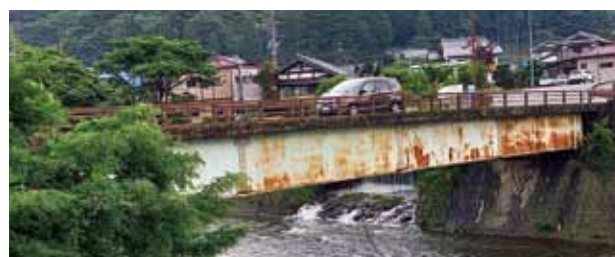
PCB塗膜調査対象 清水橋
