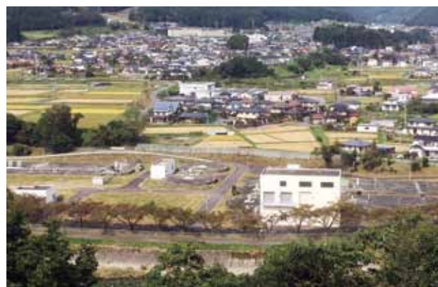
天竜川沿いの辰野水処理センター全景
