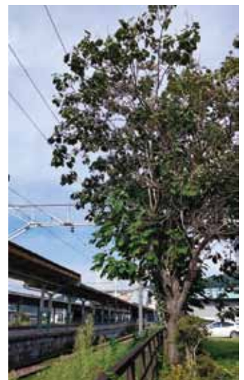
高圧線に接触している樹木
