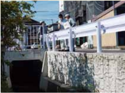
道路拡幅と水路改良工事
