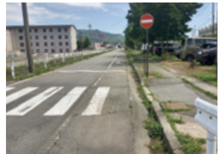
町道8号線の現状
