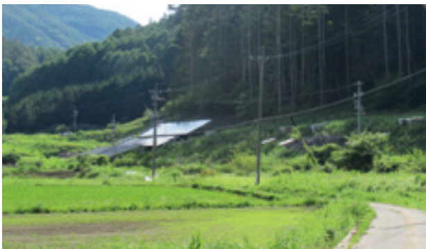
事業者が倒産し放置されている現場
