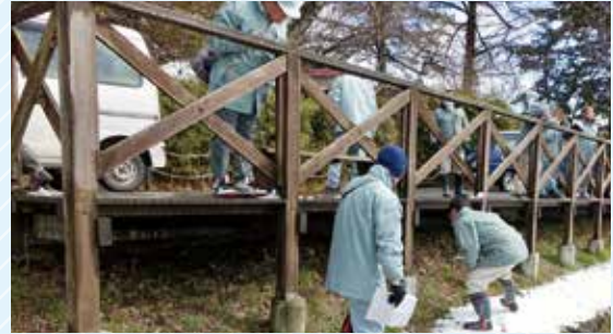
ほたる童謡公園下辰野側 展望デッキ改修工事
