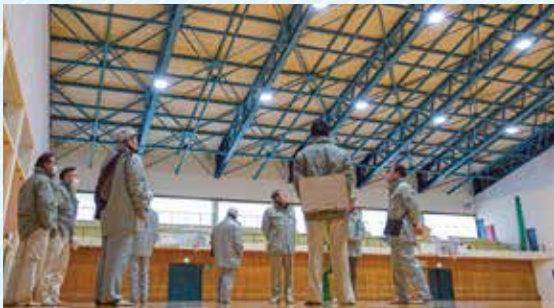
公園施設長寿命化対策工事（荒神山公園町民体育館）
