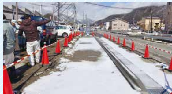
通学路緊急対策交通安全事業 町道8号線工事
