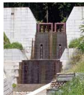
宮木楡沢砂防堰堤
