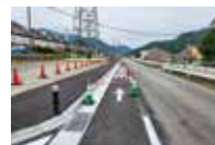
改修中の町道
