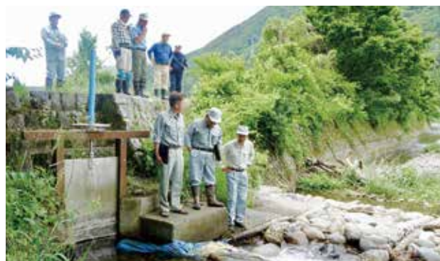
唐木沢区 水路頭首工付近
