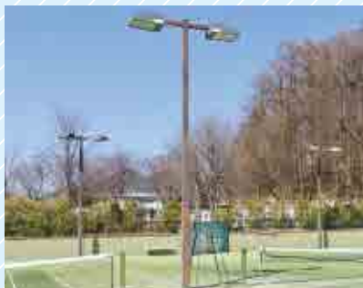
荒神山テニスコート周辺 照明LED化改修工事
