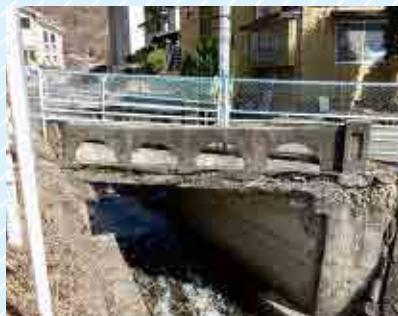
平出保育園前 上野川橋補修工事
