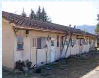
平出団地解体工事
