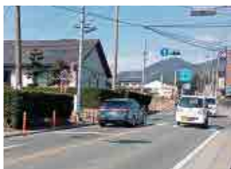
国道153号の歩道
