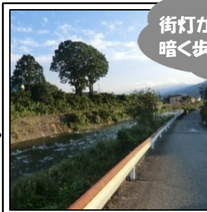
⑦堤防道路
