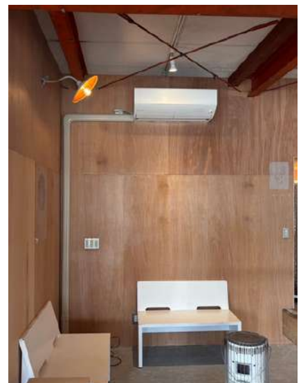
▲エアコンを設置
