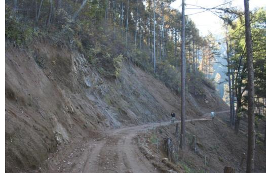
写真 4-5 急傾斜地に作設した作業道
