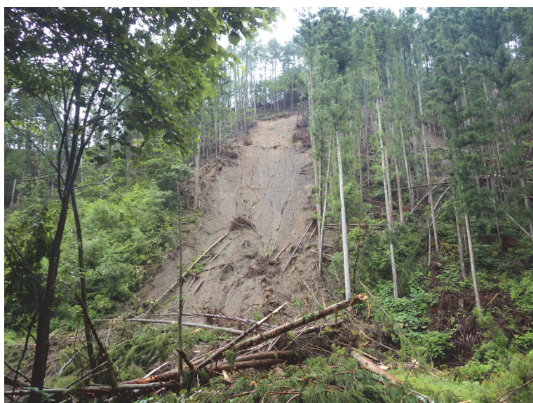
写真 2-1 令和2年豪雨災害で被災した西部線
