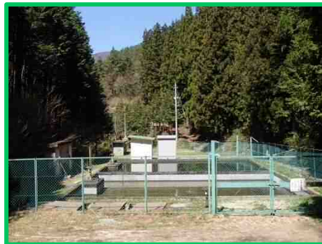
七蔵寺浄水場
