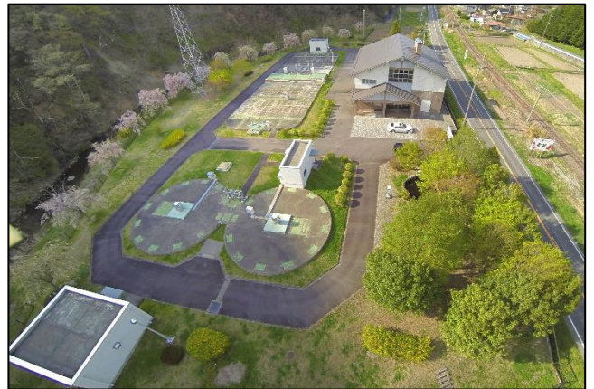
小野水処理センター全景
