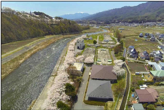
辰野水処理センター全景
